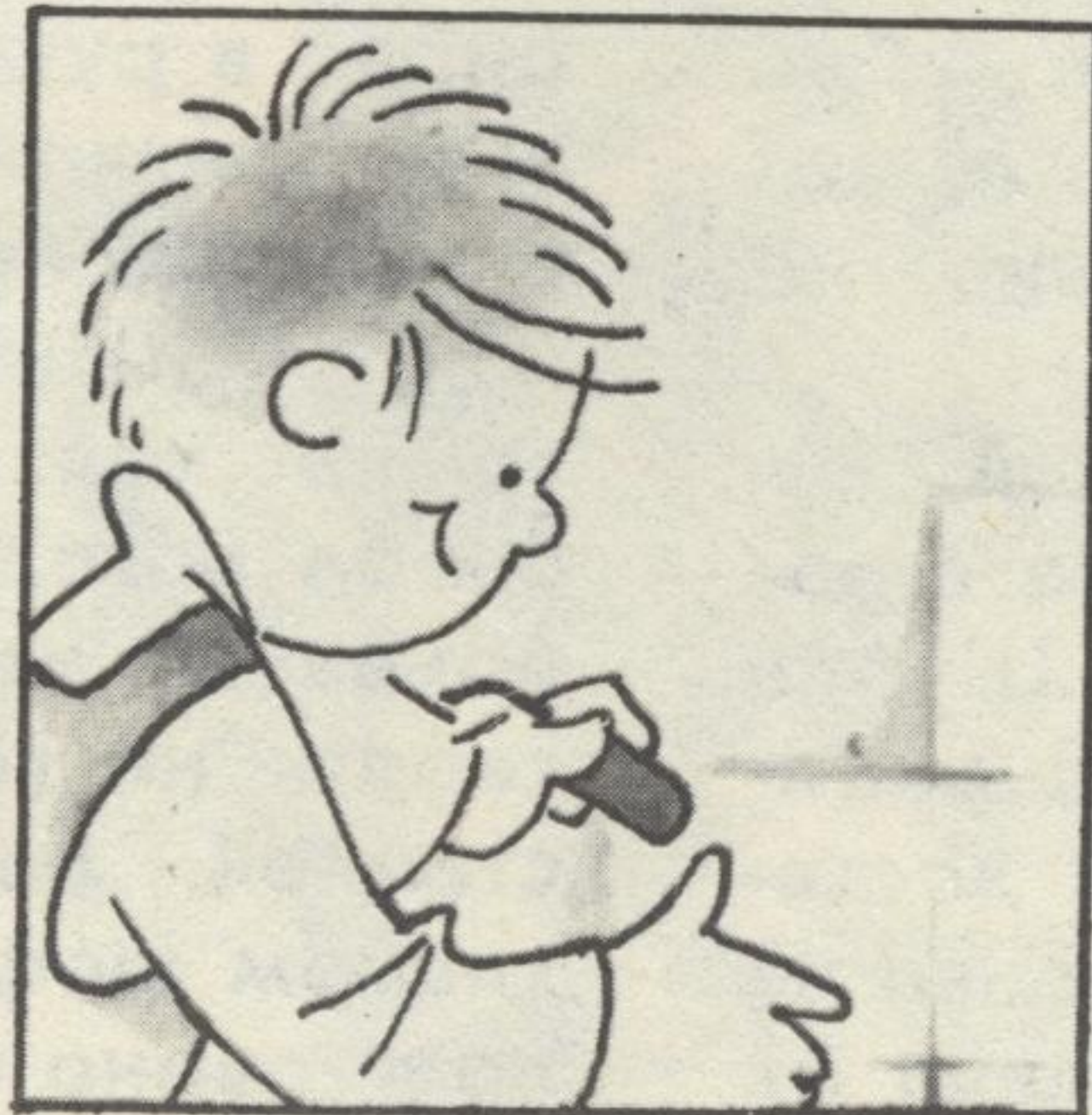
— плитка осаживается до общего уровня ряда.
